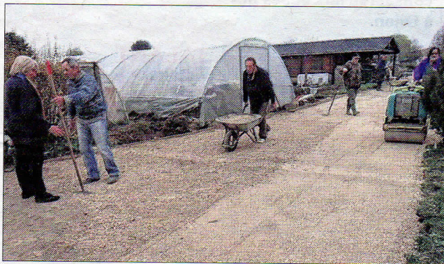
Travaux sur une des allées principales, près de la serre.
